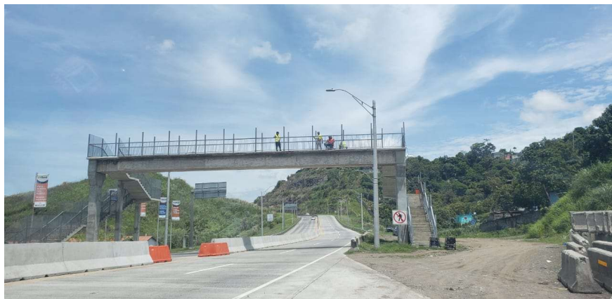
PUENTE PEATONAL RAMAL VILLA LUCRE
