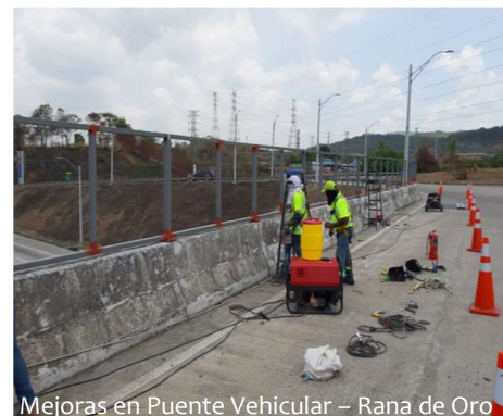
Mejoras en Puente Vehicular – Rana de Oro
